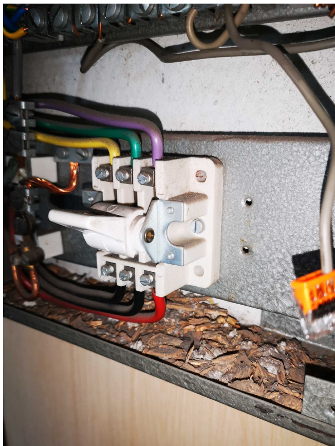
Kuvat 3 ja 4. Sähkökeskuksessa sinne kuulumatonta materiaalia eli pölyä ja roskaa.
