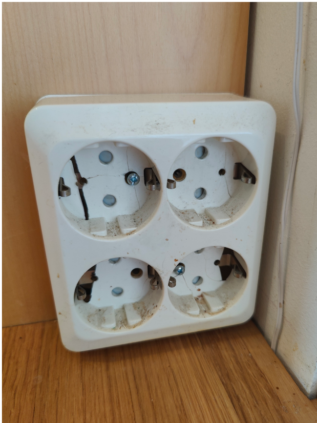
Kuvat 8 ja 9. Rikkoutuneita pistorasioita.
