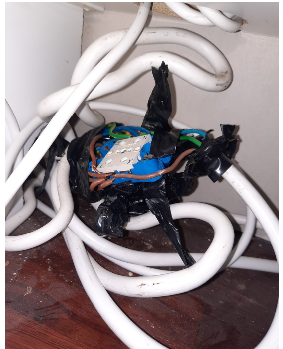
Kuva 19. Pistorasian runkoa käytetty johtimien jakajana.
