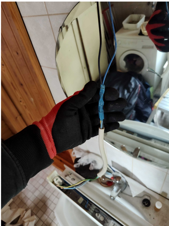
Kuva 12. Teippijatkokset putkesta: ei-ammattilaisen tekemä liitos.
