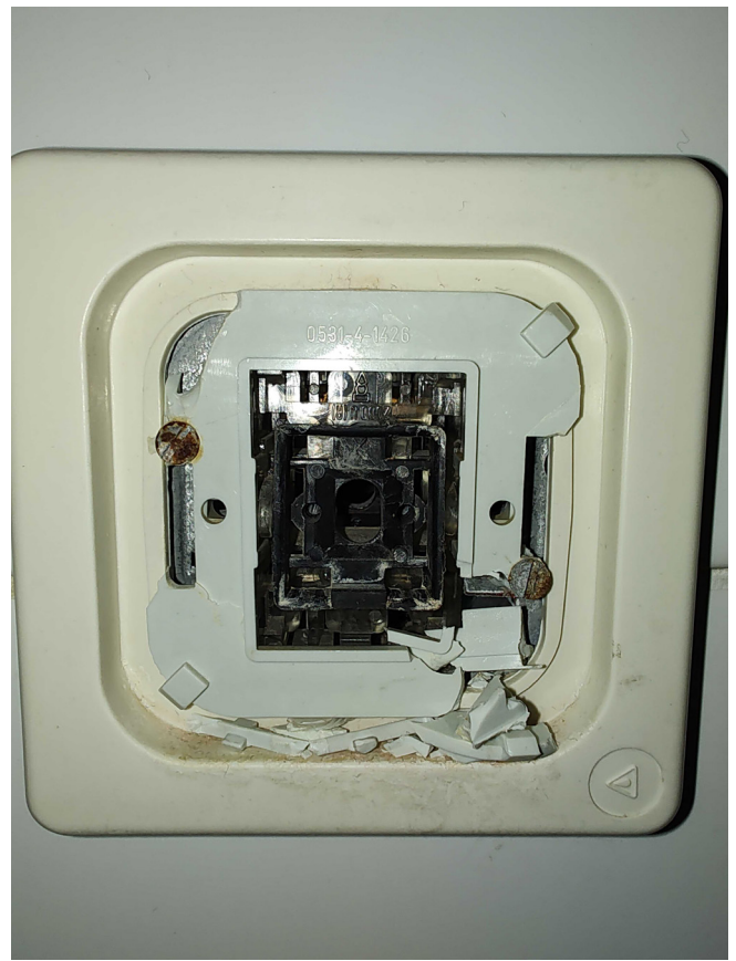
Kuvat 8 ja 9. Rikkoutuneita sähkökalusteita. Pistorasia ja kytkin haurastuneet käyttökelvottomiksi.
