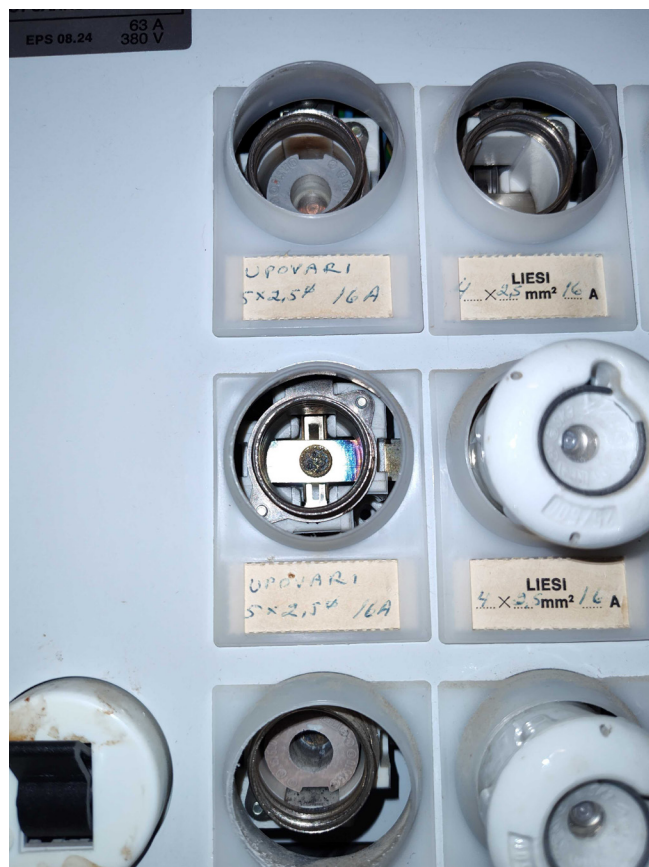
Kuvat 3 ja 4. Sähkökeskuksessa hiirenpesä ja sulakekeskuksessa murtuneet sulakepohjat.
