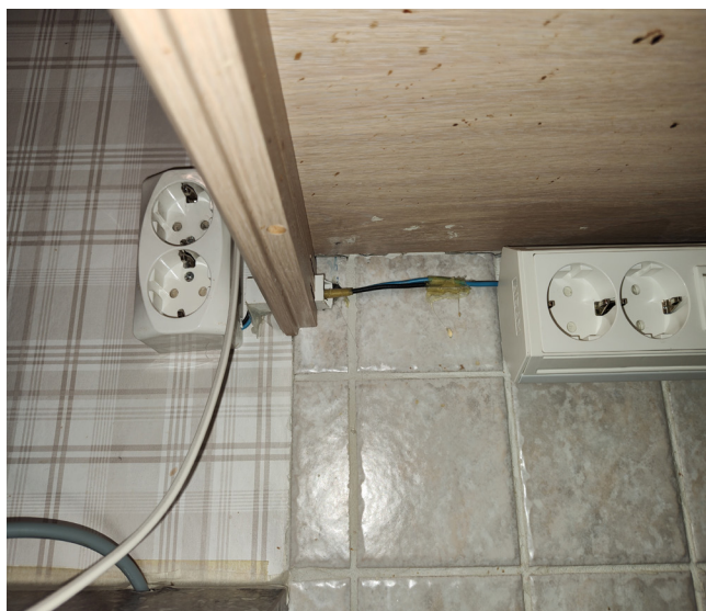
Kuva 25. Keittiön lisätty pistorasia ilman johtimien kuorta — ei-ammattilaisen tekemä.
