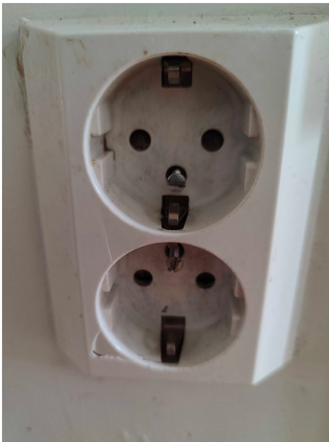
Kuvat 8 ja 9. Rikkoutuneita sähkökalusteita. Pistorasia ja kytkin haurastuneet käyttökelvottomiksi.
