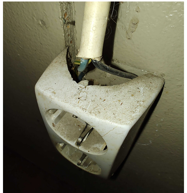
Kuva 32. Täysin hajonnut pistorasia, josta johtimet ovat suoraan kosketeltavissa.
